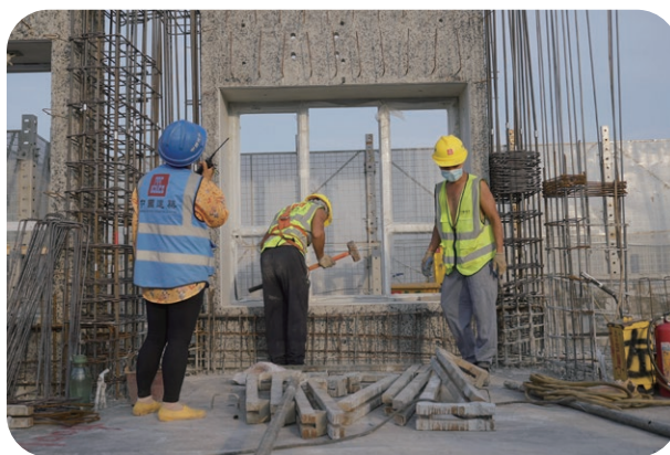
工人正在安裝預製組件
