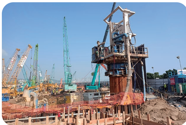
「P」地段項目全面開展新造樁基礎工程
