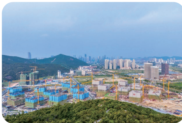
「澳門新街坊」上蓋工程全面開展 (小橫琴山方向)
