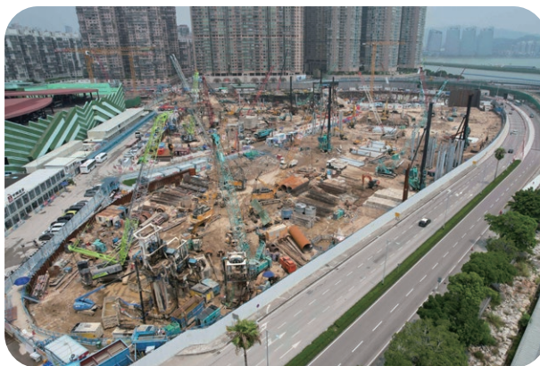
「P」地段基坑支護及地庫開挖階段工作
